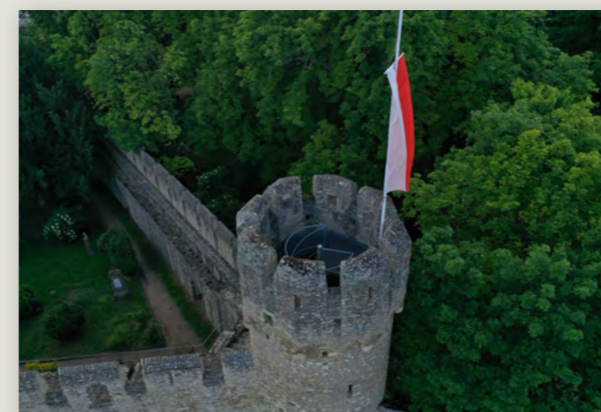
Luftbild von der Drohne aus: Umwehrung der Burgkirche mit Nordturm. Aus einer Vielzahl von Fotografien aus unterschiedlichen Blickwinkeln wird ein digitales 3D-Modell zusammengesetzt. Bei der Erfassung der Maueraufsichten kommt die Drohne zum Einsatz.
