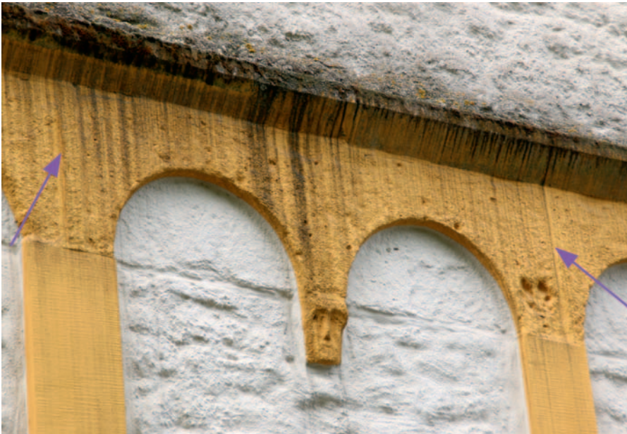
5 Turm, Nordseite, Erdgeschoss, Detail
