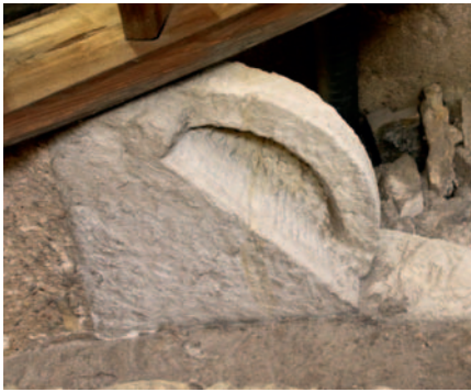
7 Kragstein mit Henkel, im 2. Obergeschosse des Turms vermauert
