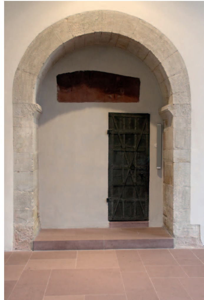
8 Vermauerte Bogenöffnung am Turm zum Mittelschiff hin
