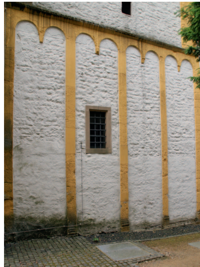
4 Turm, Nordseite, Erdgeschoss
